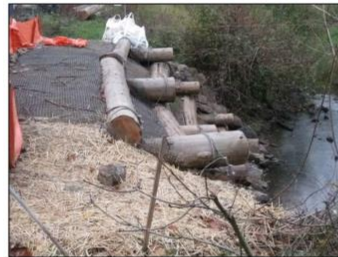
Esimerkkikuva olkikatesuojasta eroosiota vastaan, Destian hulevesiselvitys Häriskiven kaava-alueelta, 2019
